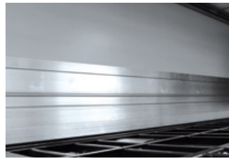
Oberwand aus Alu-Wabenplatte, Unterwand aus Alu-Profilen
